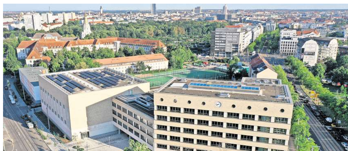
Nach zweieinhalb Jahren ist der Neubau der Johanna-Moosdorf-Schule, ehemals Prager Spitze, nun fertiggestellt. Es ist das höchste Schulgebäude der Stadt. FOTO: ANDRÉ KEMPNER
