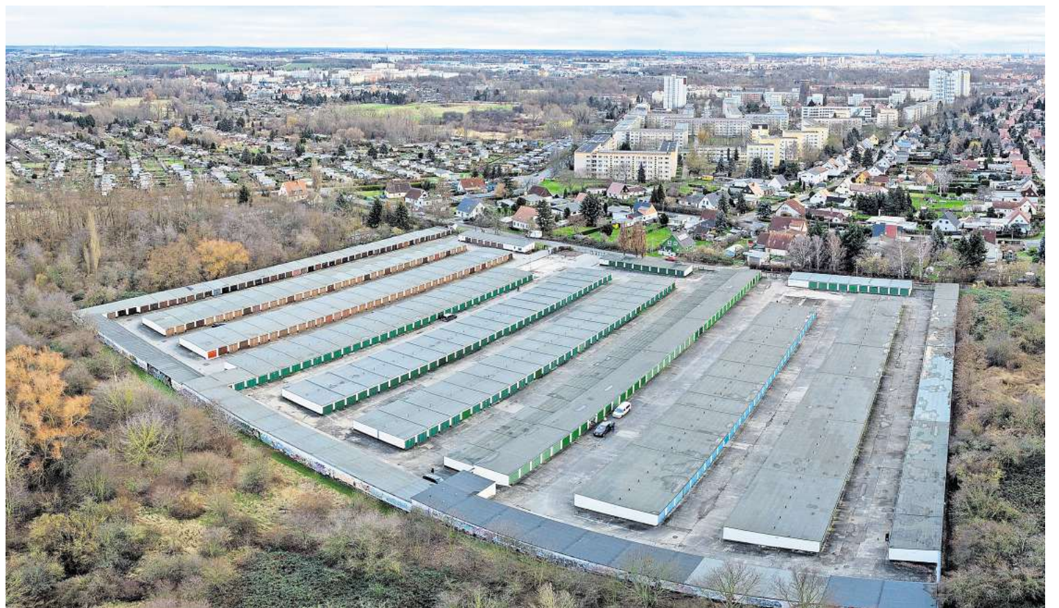
788 Garagen stehen am Rande des Wohngebietes Mockau-Ost. Die Garagengemeinschaft will die 1,5 Hektar große Dachfläche zur Erzeugung von Solarstrom nutzen. FOTO: WOLFGANG SENS
